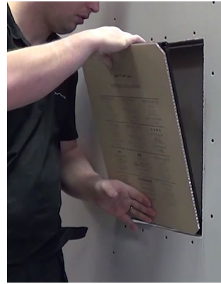
3.ボックスにスピーカーを固定する
