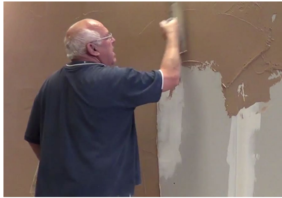
6.漆喰、土壁等で壁面全体に処理します
